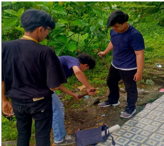
Gambar 4. Pembuatan sumur resapan sederhana
